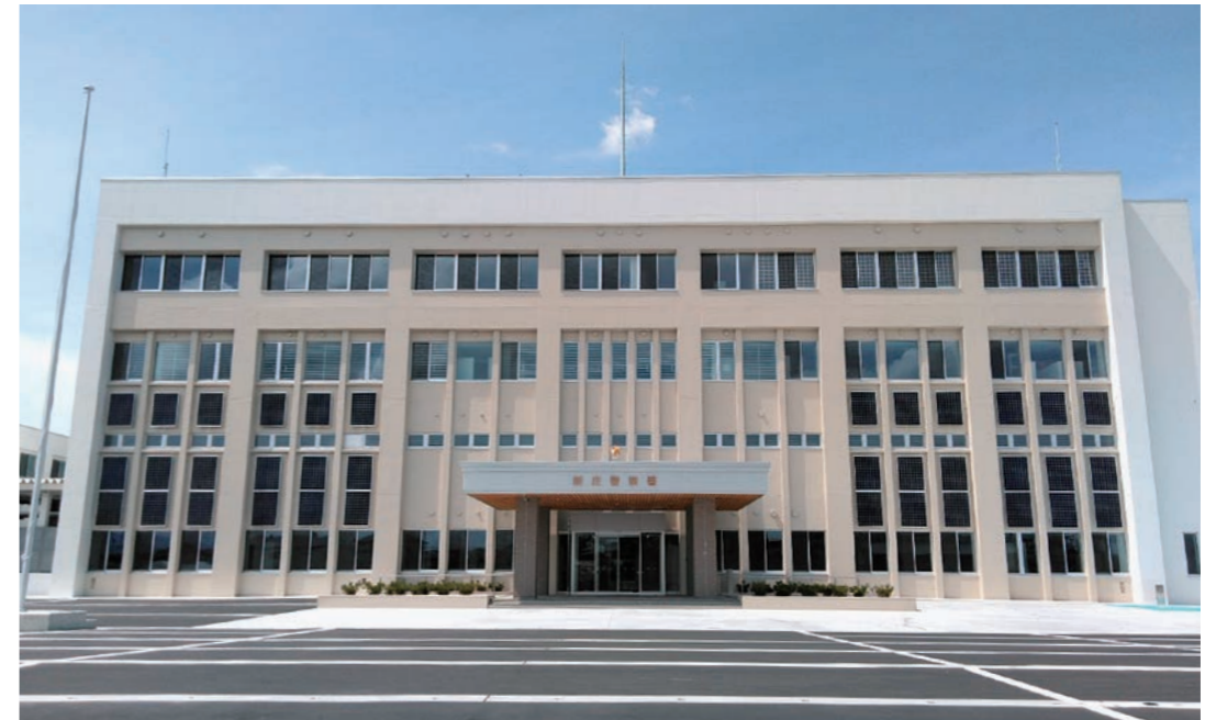
新庄警察署庁舎改築工事
