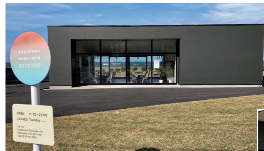
ゆのはま100年キッチン 電気設備工事
