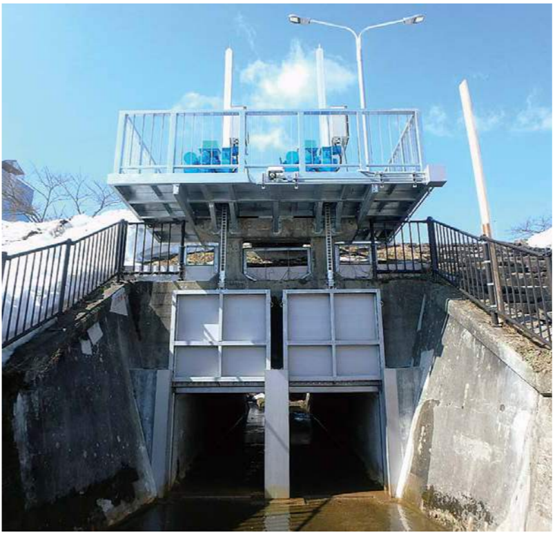
最上川上流樋管等ゲート設備更新工事(木蓮川樋管)
