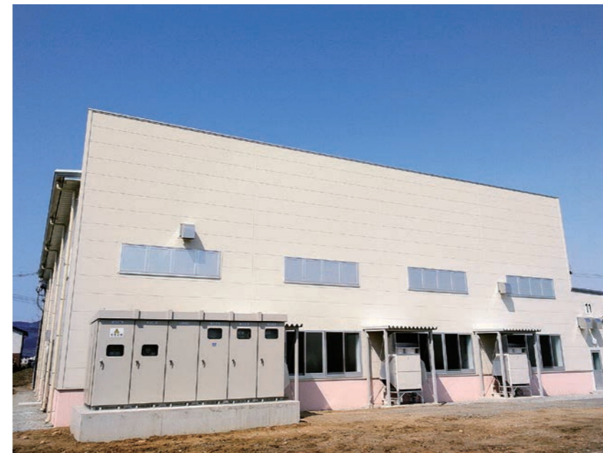
光洋精機(株)工場増築工事(電気設備工事)
