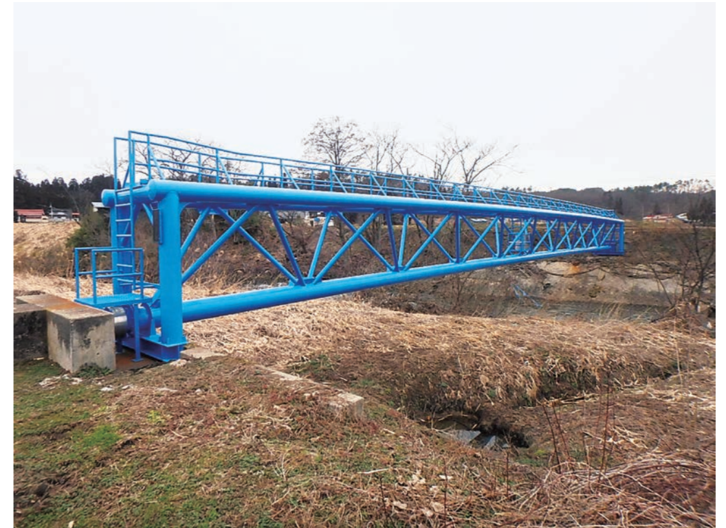
熊野堂水管橋整備補修工事
